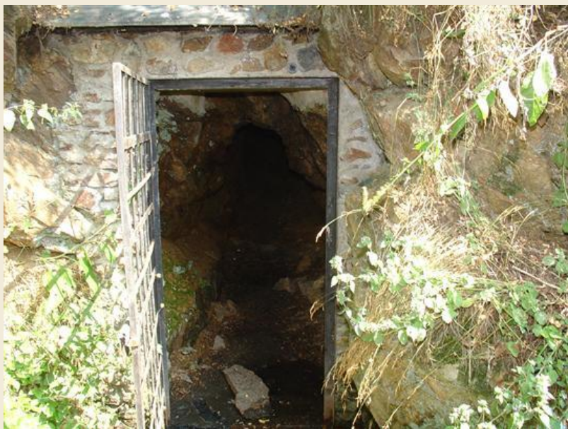
Vchod do štoly
