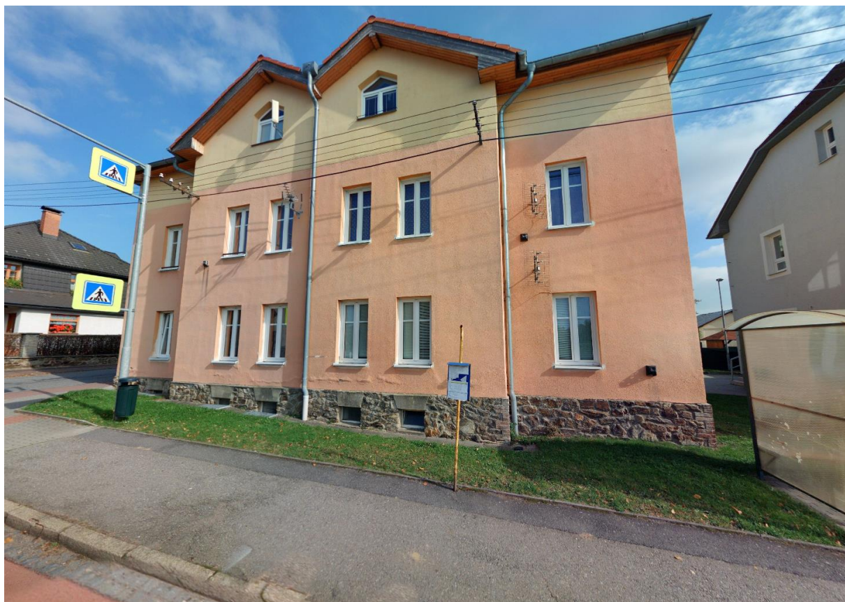
Celkový pohled na objekt, suterénní zdivo provedeno z exteriéru jako kamenné
