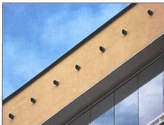
Ukázka nesprávného provedení opatření, trubky vyčnívají spodními okraji ze zateplené fasády a jsou pro roryse jen obtížně překonatelnou překážkou
